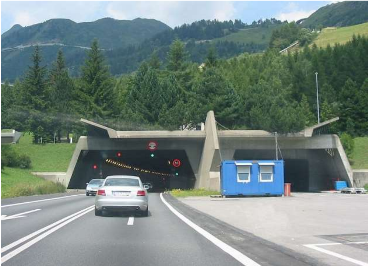
Entrée sud du tunnel du Gothard
