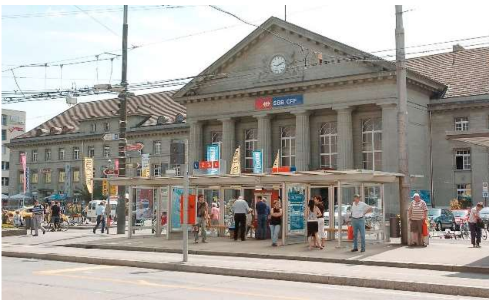
Gare actuelle (2010). L'extérieur a peu changé, mais l'intérieur a complètement été transformé.
